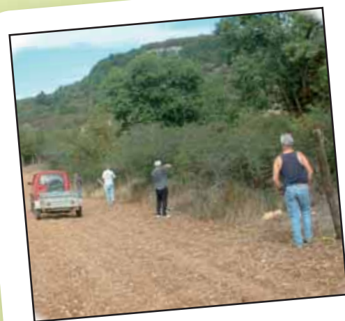
Installation d'une clôture
